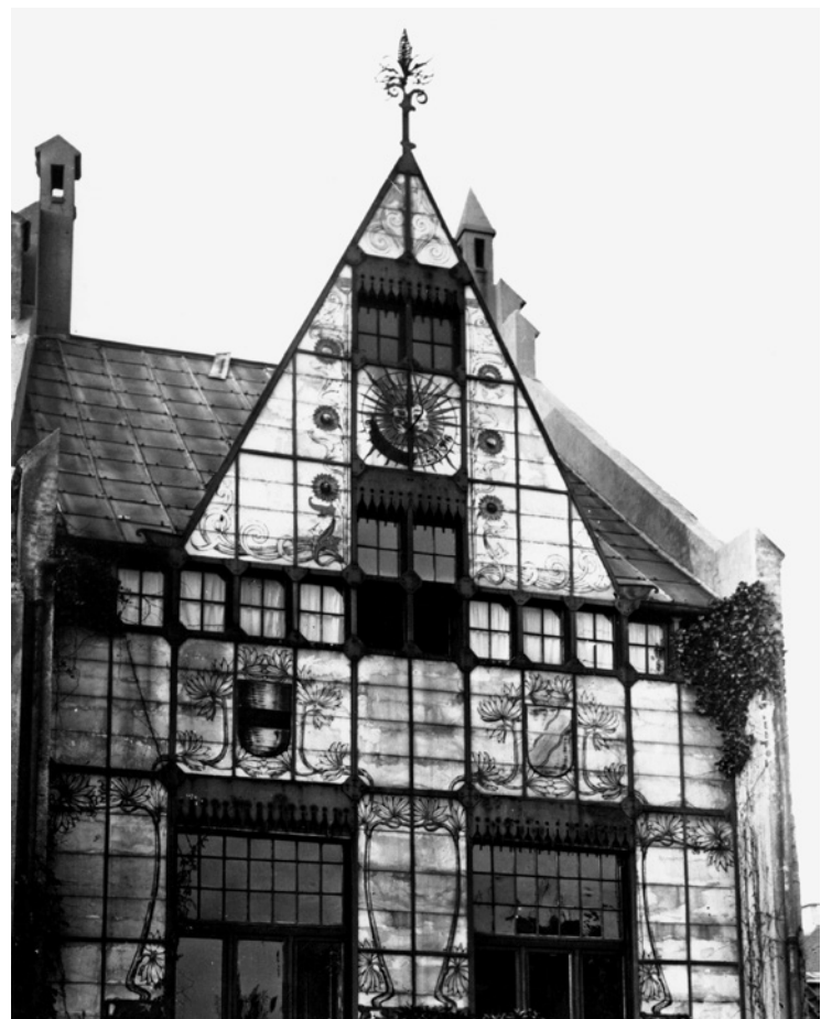
Abb. 9: St.-Anton-Straße 91, Krefeld, Fassadendetail im Ursprungszustand
