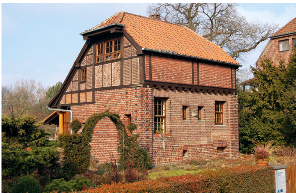
Abb. 18: Mutterhäuschen, Moerser Landstraße 18 in Krefeld, 1910 von Buschhüter für seine Mutter errichtet
