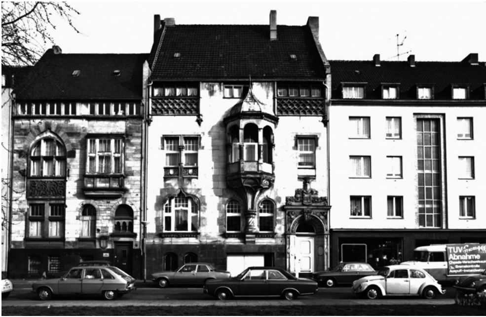
Abb. 4: Bismarckplatz 15 (links), 11 (Mitte), Krefeld, beide von Buschhüter errichtet und nach Beschädigung im Zweiten Weltkrieg vereinfacht wiederhergestellt (Foto aus den 1970er Jahren)
